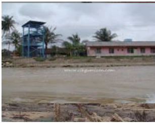
Flooding in front of Sekolah Kebangsaan Pulau Beluru
